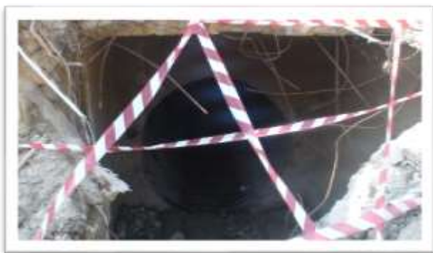
Fig 34 – Foto dell'alveo del T.te Bardano sotto il ponte della Ferrovia fatto scorrere in una sezione in cls larga poco più di 1 m e foto del tratto intubato subito a valle dello stesso ponte, dove si è verificata l'ostruzione con i conseguenti danni durante i fenomeni alluvionali del 2010-2011
