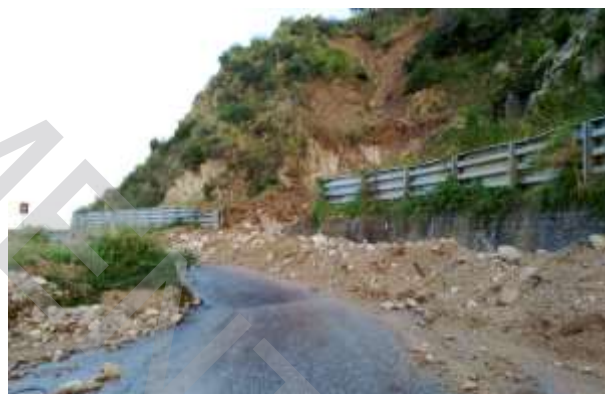
Fig. 10 - Foto Strada per Daffinà: evidenti fenomeni di dissesto con frequenza più elevata in corrispondenza delle incisioni torrentizie
