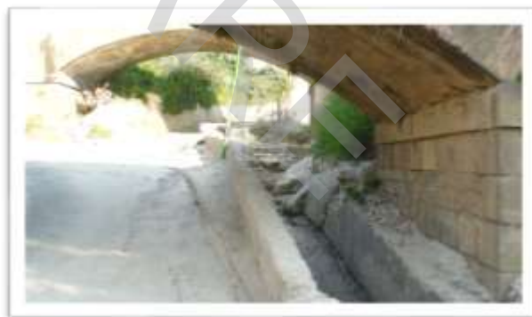
Fig 34 – Foto dell'alveo del T.te Bardano sotto il ponte della Ferrovia fatto scorrere in una sezione in cls larga poco più di 1 m e foto del tratto intubato subito a valle dello stesso ponte, dove si è verificata l'ostruzione con i conseguenti danni durante i fenomeni alluvionali del 2010-2011
